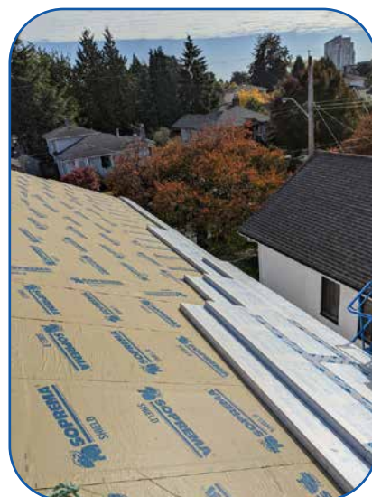
Figure 3 Isolation rigide en XPS installée sur la membrane pare-vapeur en préparation de la pose des lattes structurales.
