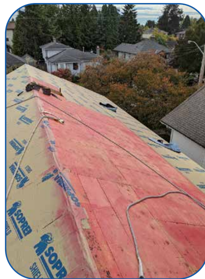
Figure 2 Membrane pare-vapeur auto-adhésive (beige) collée avec un apprêt époxydique sur le platelage en bois (rouge).
