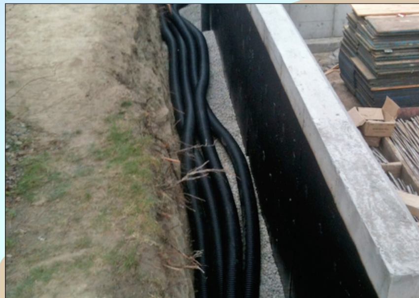
Figure 3. Tubes dans la tranchée avant le remblayage.
