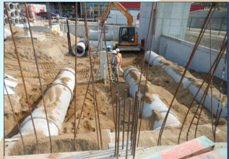
Figure 3. Tubes dans la tranchée avant le remblayage.
