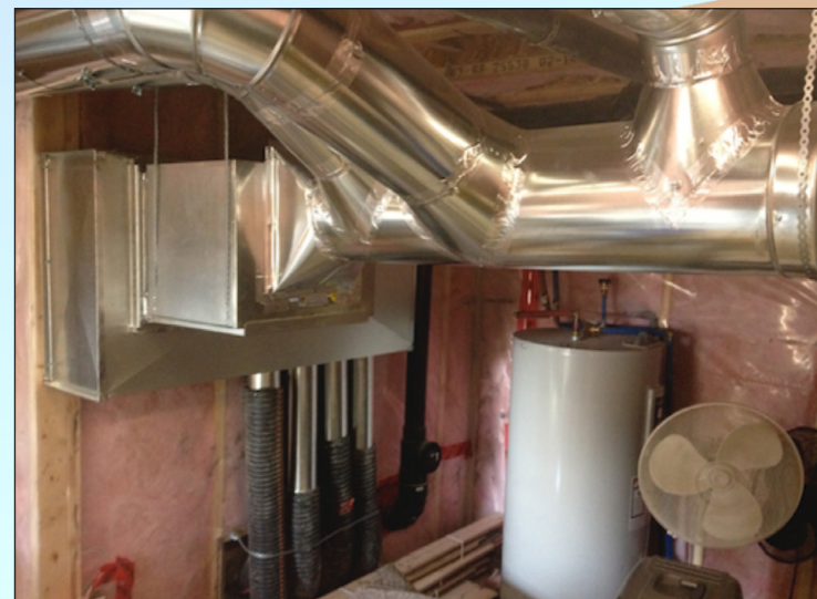
Figure 1. Configuration des tubes raccordés au ventilateur et aux conduits d'alimentation.
