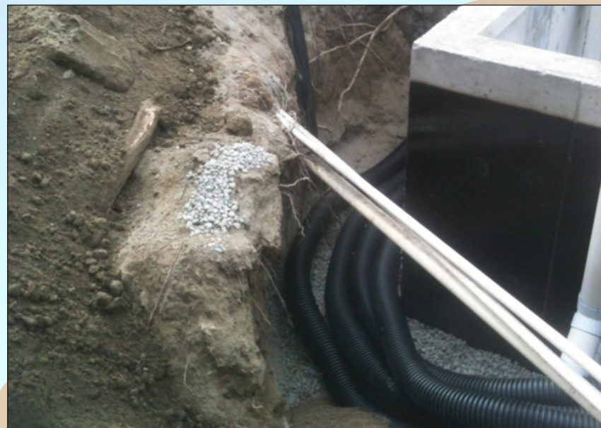
Figure 3. Tubes dans la tranchée avant le remblayage.
