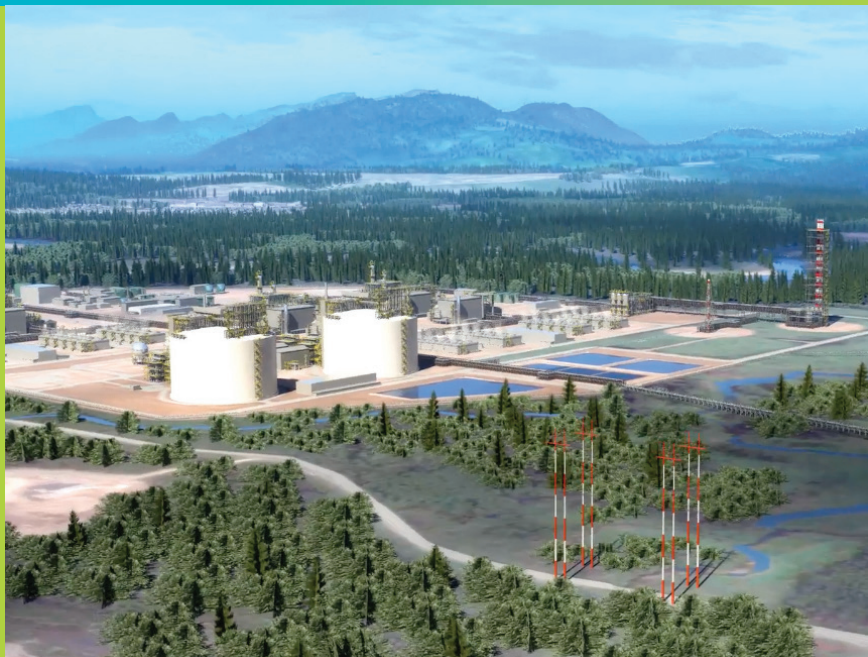
Crédit photo : LNG Canada
