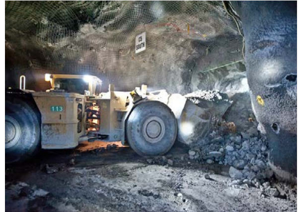
Photo : New Gold Inc. Une pelle nettoie un entonnoir de soutirage souterrain. La pierre suspendue tombe dans l'entonnoir pour être extraite.
