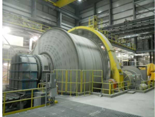
Photo : New Gold Inc. Le broyeur SAG de 7 500 HP en opération dans le circuit de broyage.
