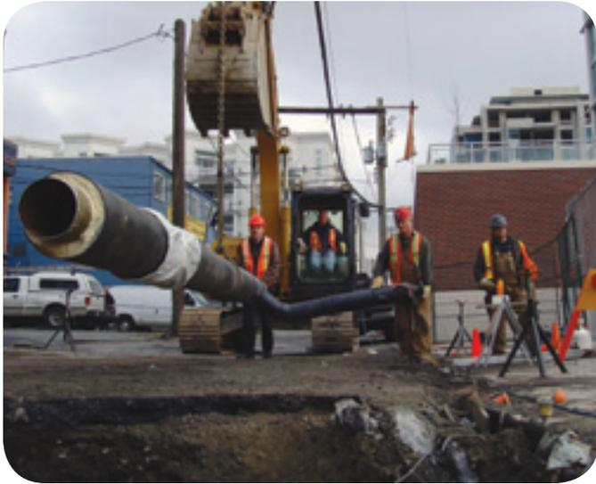
Des conduites de chauffage du quartier raccordent l'approvisionnement en énergie thermique aux immeubles des clients.
