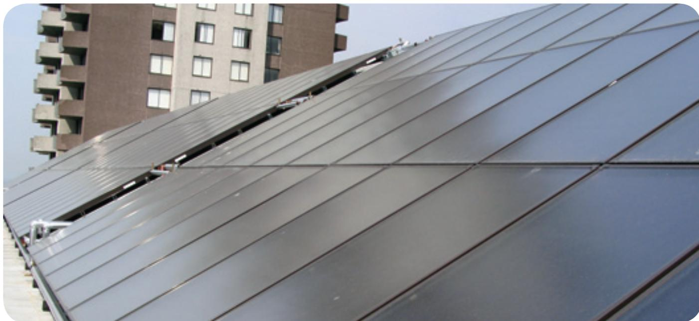
*Du chauffage renouvelable obtenu au moyen de capteurs solaires sur toit est distribué par un système communautaire d'énergie. (Lonsdale Energy Corporation, North Vancouver, Colombie-Britannique)*
