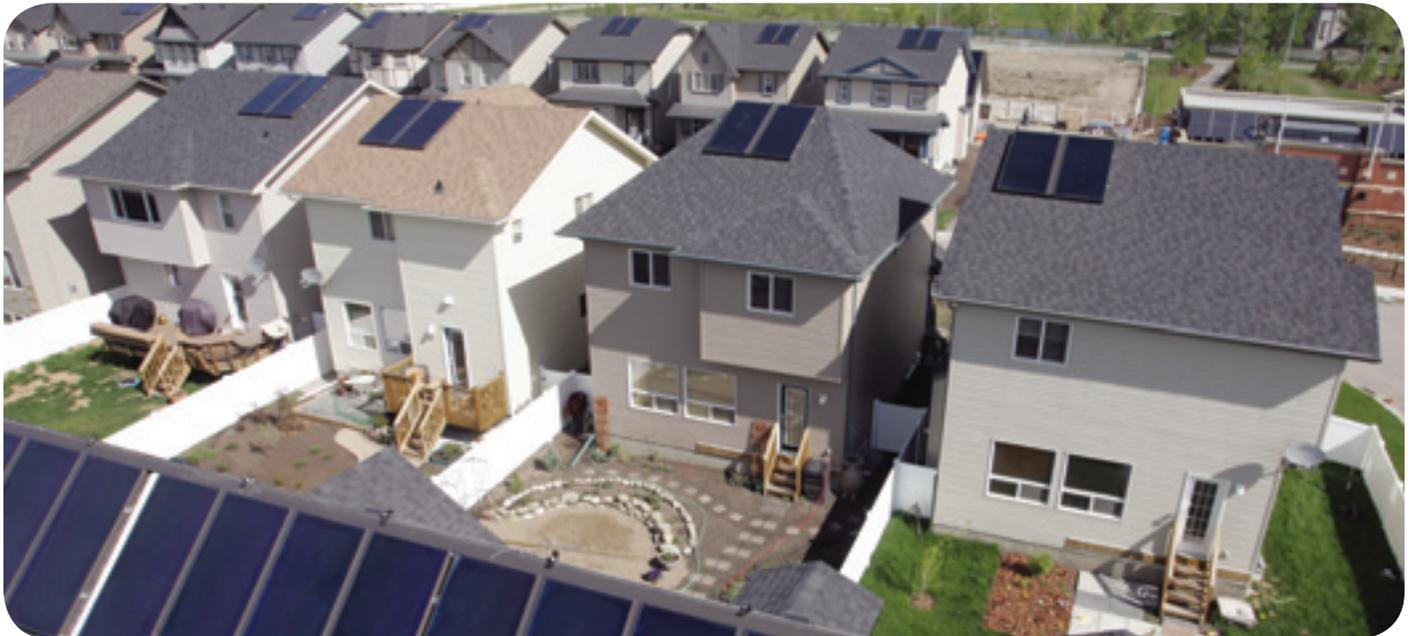
*L'énergie solaire chauffe des maisons à haut rendement énergétique au moyen de capteurs solaires, d'un stockage thermique saisonnier et d'un système de chauffage communautaire.
